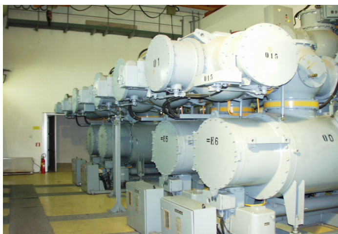
Slika 1. VN GIS postrojenje u TS 110/10 (20) kV Ksaver (Zagreb)
