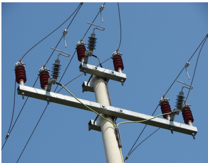
Slika 6. Glava 20 kV stupa s ugrađenim linijskim odvodnicima prenapona pojačana električki i mehanički zbog prijelaza preko ceste
