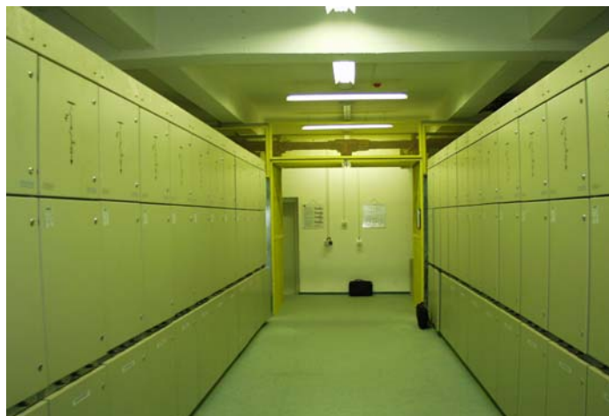
Slika 2. SN postrojenje tipa KSMA u TS 110/10 (20) kV Rakitje (Zagreb)
