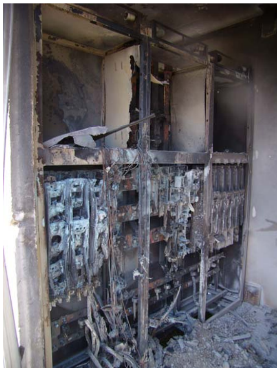
Slika 1. Niskonaponski sklopni blok nakon požara
