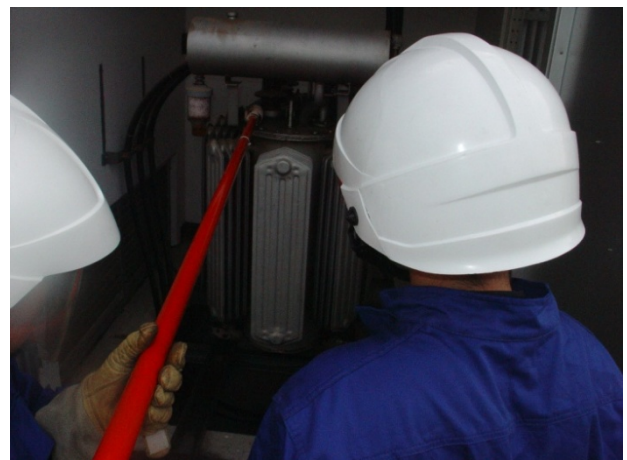
Slika 4. Čišćenje dijelova na transformatoru sa zaobljenom četkom
