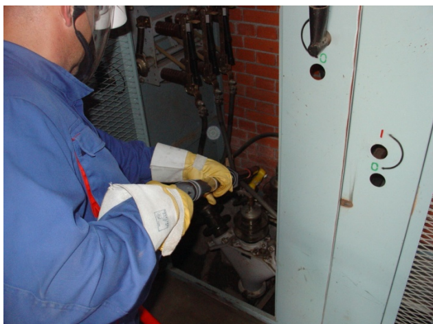
Slika 5. Čišćenje ćelija unutar KTS-a
