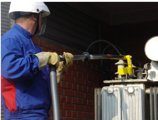
Slika 4. Čišćenje dijelova na transformatoru sa zaobljenom četkom
