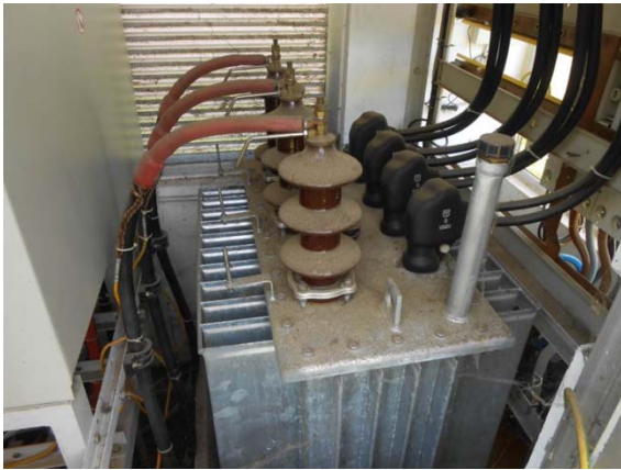
Slika 7. Čišćenje TS 10(20)/0,4 kV KRIŽ 19- VTS VINOGRADSKA-prije i poslije čišćenja
