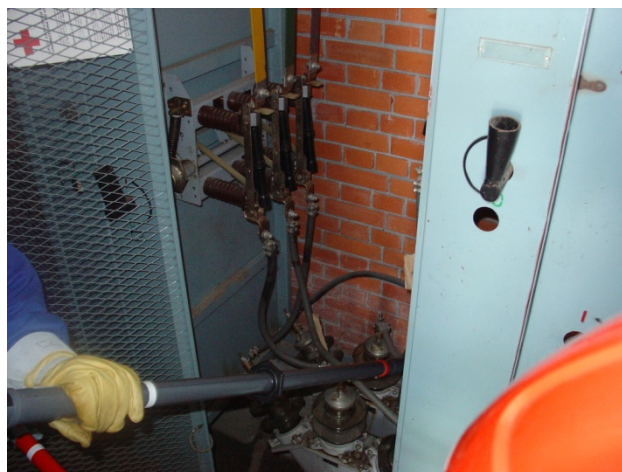
Slika 5. Čišćenje ćelija unutar KTS-a
