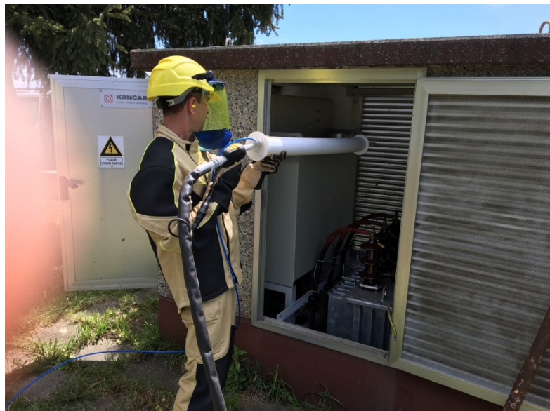
Slika 8. Čišćenje TS 10(20)/0,4 kV KRIŽ 19- VTS VINOGRADSKA
