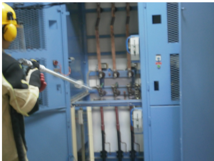
Slika 6. Čišćenje ćelija unutar postrojenja HEP NOC Velika
