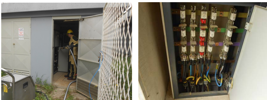
Slika 10. Čišćenje TS 20/0,4 kV CENTAR IČIĆ
