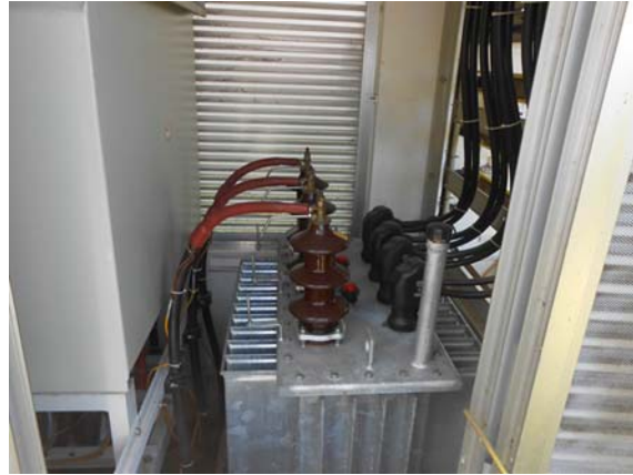
Slika 7. Čišćenje TS 10(20)/0,4 kV KRIŽ 19- VTS VINOGRADSKA-prije i poslije čišćenja
