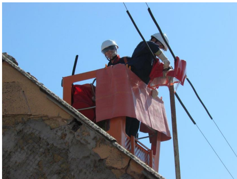
Slika 6. Elektromonter Elektroslavonije Osijek Pogon Beli Manastir pri radu pod naponom
