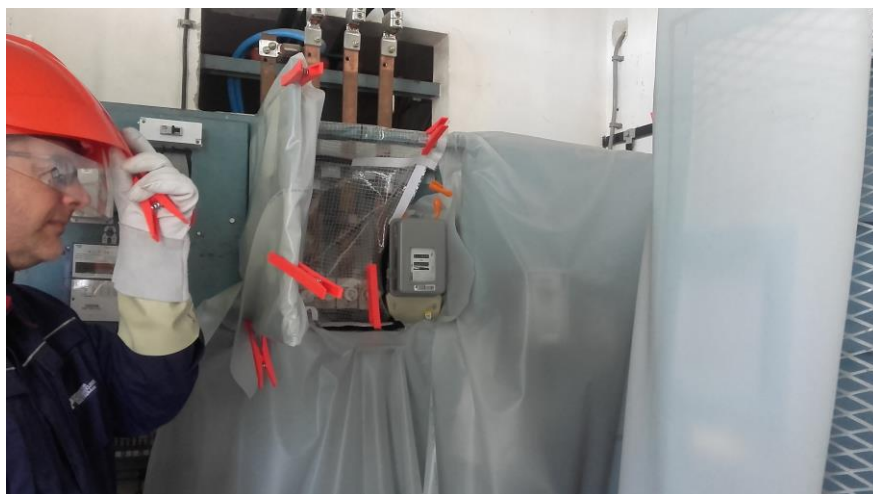
Slika 5. Elektromonter Elektroslavonije Osijek pri radu pod naponom
