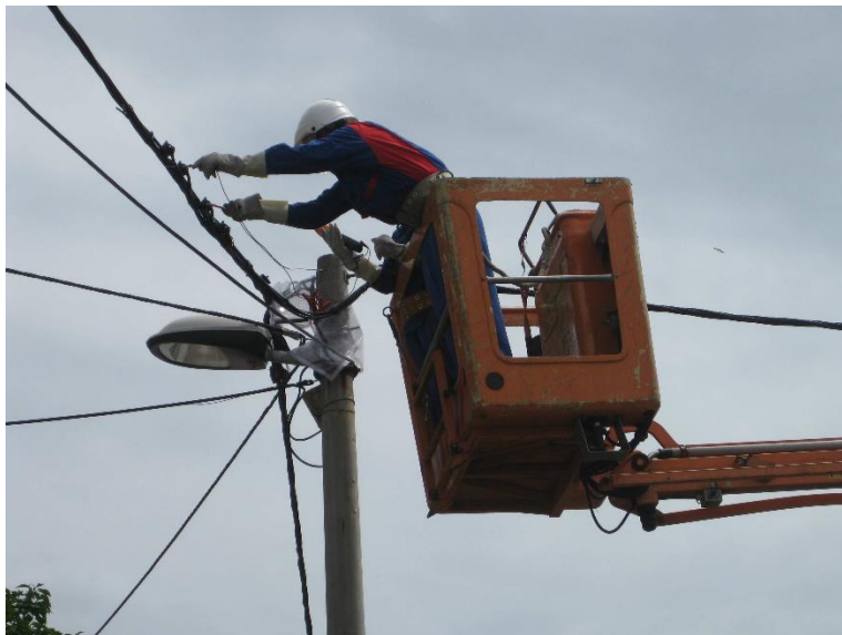
Slika 4. Elektromonter Elektroprimorja pri radu pod naponom
