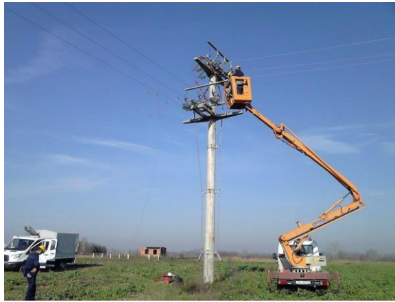
Slika 6. Ugradnja zaštitnih prečaka, izolacijskih cijevi i kapa na 10 KV stupu u Dubočcu
