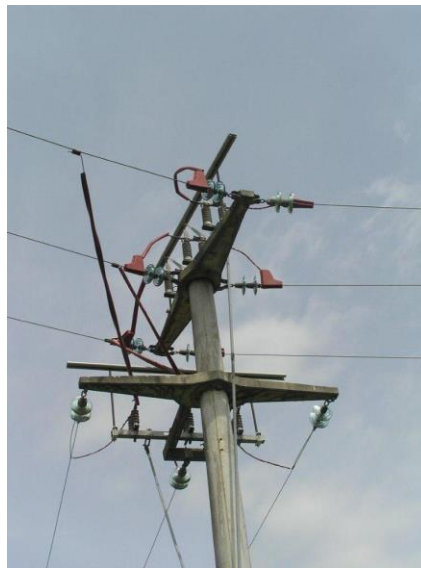
Slika 7. Ugradnja zaštitnih prečaka, izolacijskih cijevi i kapa na 10 KV stupu u Dubočcu
