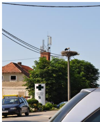
Slika 8. Gnijezdo izgrađeno na stupu niskonaponske mreže s rasvjetnom armaturom
