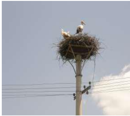
Slika 9. Gnijezdo formirano na platformi na stupu niskonaponske mreže s golim vodičima
