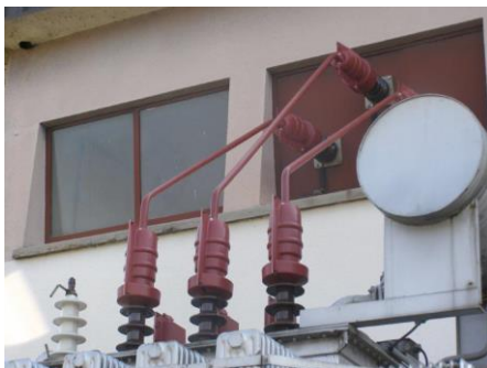
Slika 4. Izoliranje transformatora 35/10 kV (izolatori, sabirnice) u Batrini
