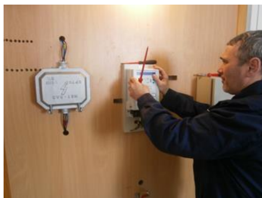
Slika 1, 2: Zamjena brojila bez tehnologije rada pod naponom i bez osobnih zaštitnih sredstava,
