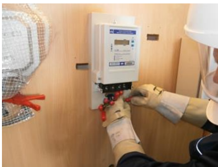
Slika 5 i 6: Odspajanje vodiča korištenjem izolacijskog alata, uz kontrolu vodiča i postavljanje izolacijskih kapica
