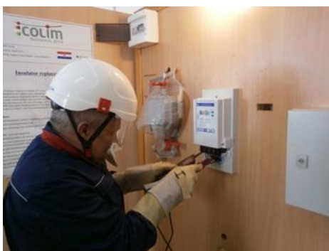
Slika 7 i 8: Zamjena brojila i provjera naponskog stanja na brojilu
