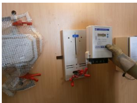
Slika 7 i 8: Zamjena brojila i provjera naponskog stanja na brojilu
