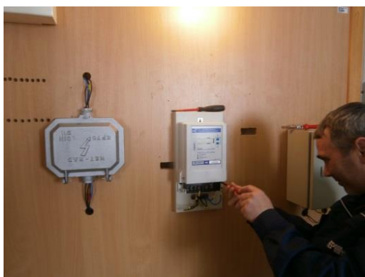
Slika 1, 2: Zamjena brojila bez tehnologije rada pod naponom i bez osobnih zaštitnih sredstava,
