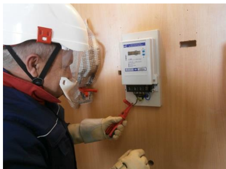
Slika 5 i 6: Odspajanje vodiča korištenjem izolacijskog alata, uz kontrolu vodiča i postavljanje izolacijskih kapica
