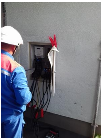
Slike 3 i 4: Premosnice su postavljene, odspajanje vodiča s brojila te izmjena brojila,
