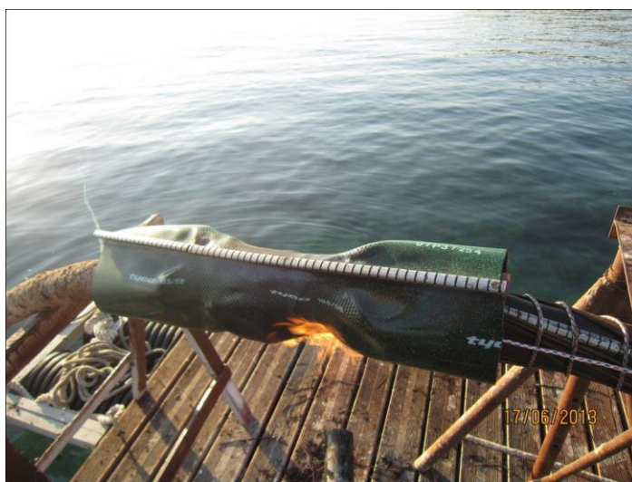
Slika 5. Izrada spojnice na splavi
