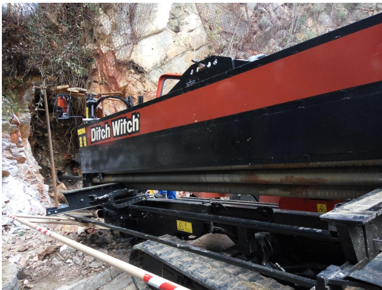
Slika 6. Izrada pilotne bušotine
