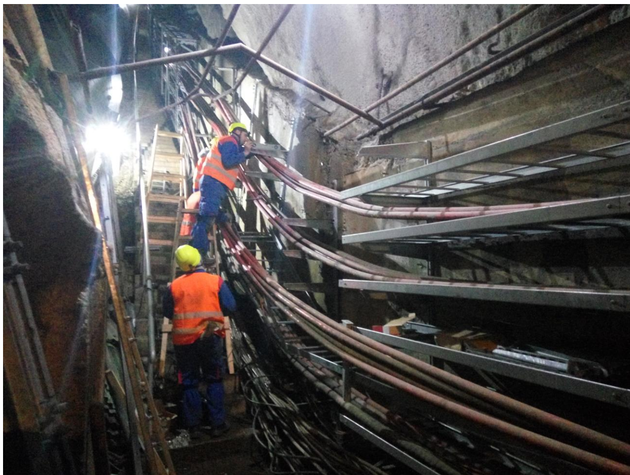
Slika 3. Postavljanje čelične konstrukcije
