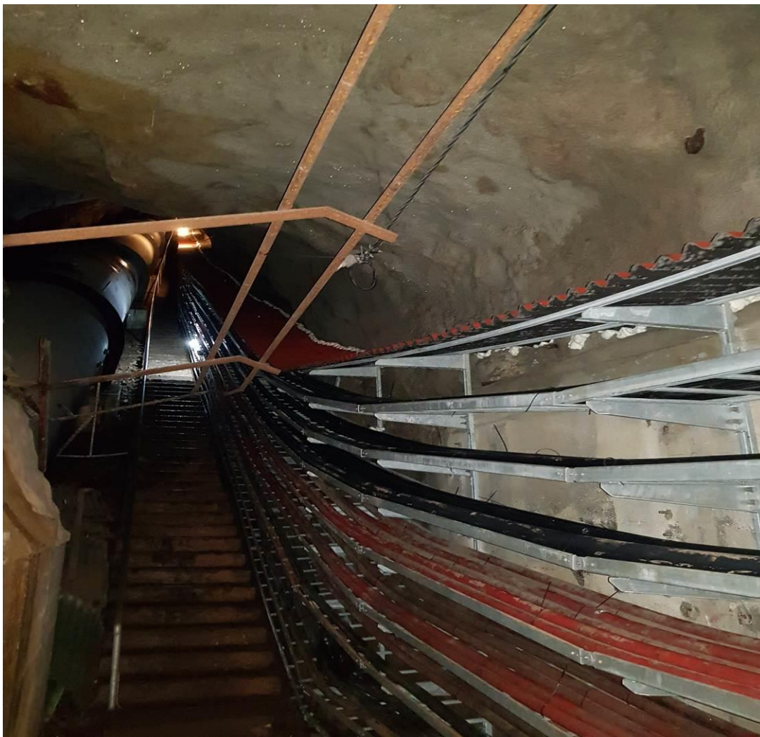
Slika 4. Dovršena metalna konstrukcija s postavljenim energetskim kabelima tip NA2XS(F)2Y 1x240 mm 2
