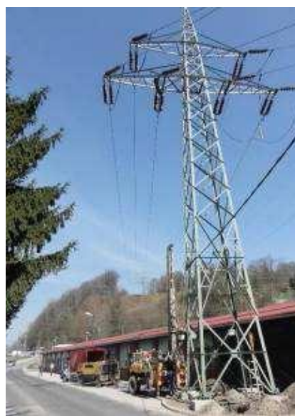
Slika 4. Ograničen prostor i bušenje za montažu štapastog uzemljivača uz 110 kV stup
