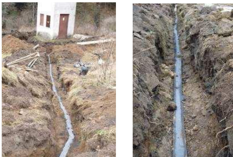
Slika 3. Trakasti uzemljivač u posteljici grafitnog praha TS Lukanja
