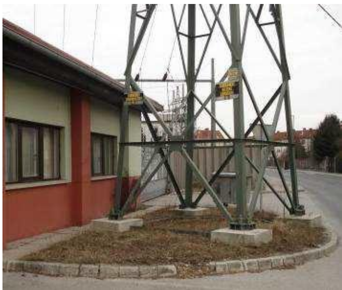
Slika 4. Ograničen prostor i bušenje za montažu štapastog uzemljivača uz 110 kV stup
