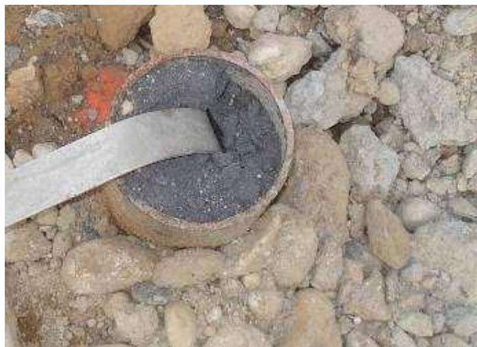
Slika 6. Štapasti uzemljivač s grafitnim prahom u šljunku
