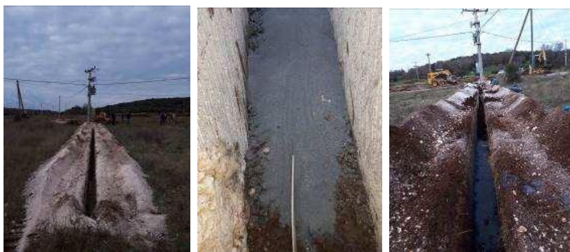
Slika 10 - 12. Struktura rova i faze polaganja inox trake i grafitnog praha
