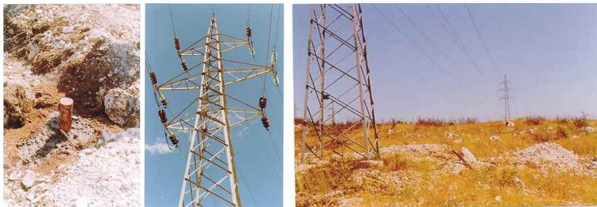
KEMIJSKA SONDA prije ugradnje šahta
