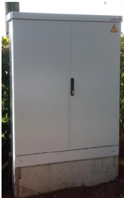
Slika 5. Način montaže ormara opremljenog regulatorom napona
