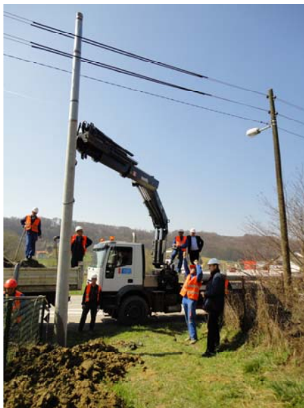
Slika 3. Podizanje betonskog stupa pod naponom u Krapinskim Toplicama ožujak 2011. godine
