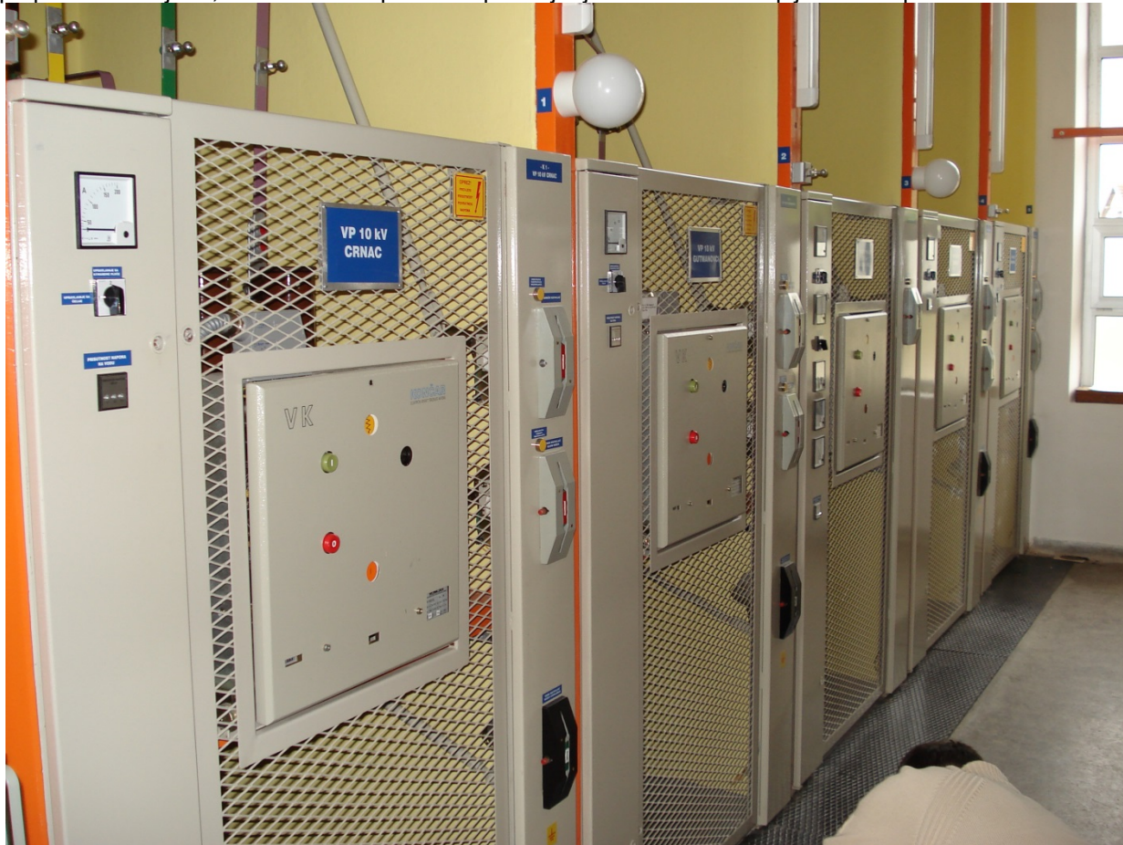
Slika 9. postrojenje 10(20)kV u klasičnoj izvedbi s ugrađenim uređajem IN-20
