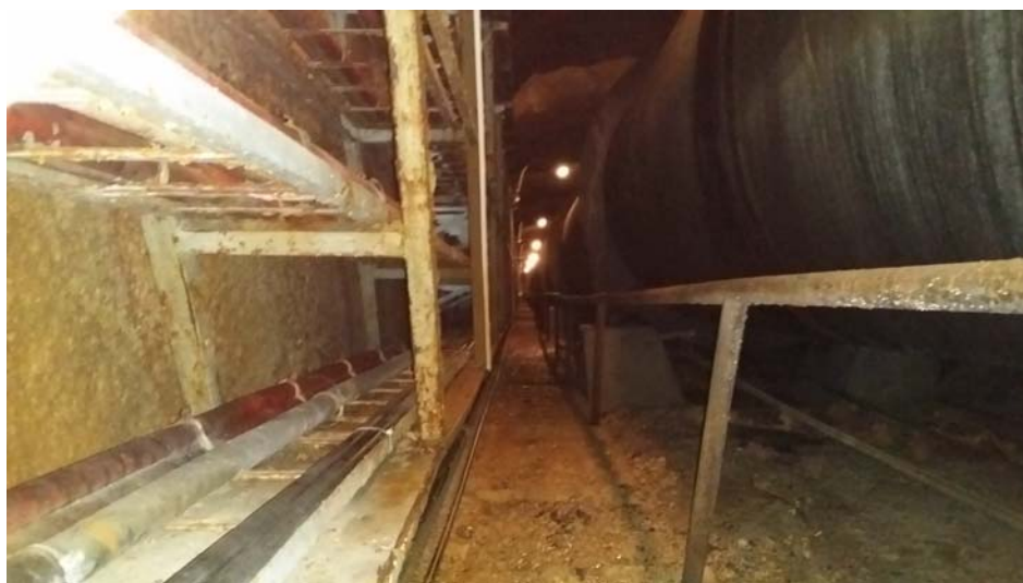
Slika 3. Tunel tlačnog cjevovoda u kosom rovu
