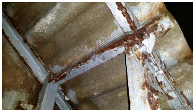
Slika 9. Utjecaj vlage na postojećoj metalnoj konstrukciji u tunelu tlačnog cjevovoda „HE Rijeka“
