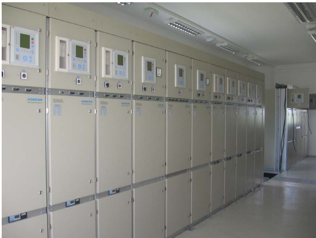
Slika 10. postrojenje 10(20)kV izvedeno s sklopnim blokovima i opremljeno s CAVIN
