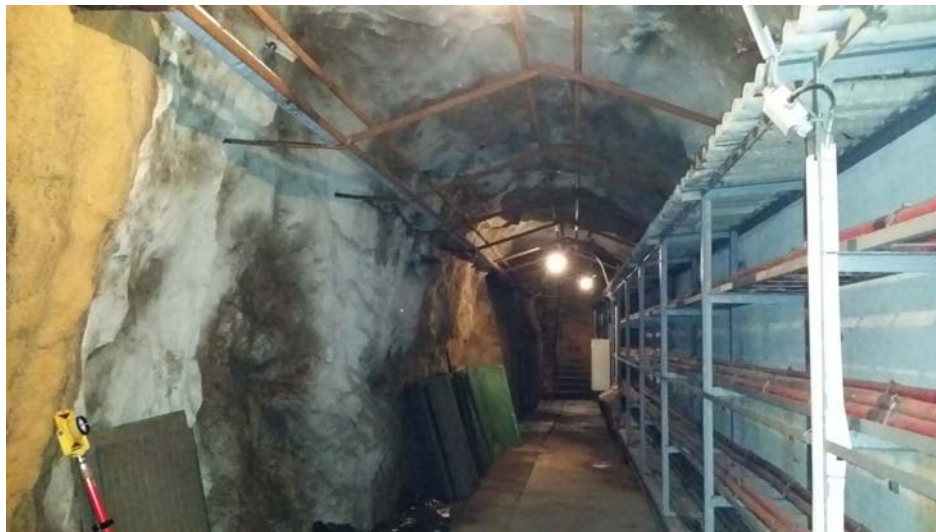
Slika 6. Kabelski tunel do strojarnice „HE Rijeka“
