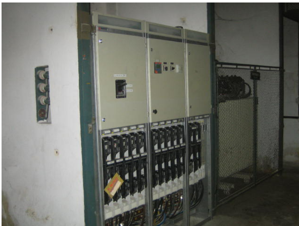
Slika 5. NN sklopni blok u rekonstruiranoj podrumskoj TS
