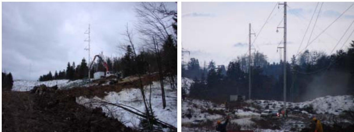
Slika 15. Postavljanje havarijskih/montažnih stupova u trasu DV 110 kV Vrhnika - Logatec [14-16]
