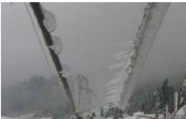
Slika 10: Led na DV 400 kV Beričevo - Divača [16]
