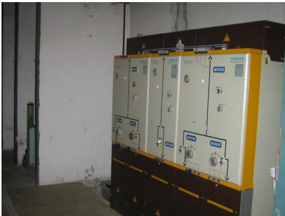
Slika 4. SN sklopni blok u rekonstruiranoj podrumskoj TS
