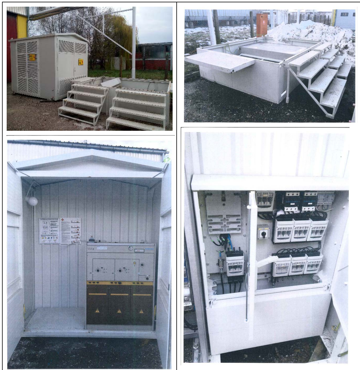
Slika 7. Mobilna TS 10(20)/0,4 kV – dijelovi trafostanice
