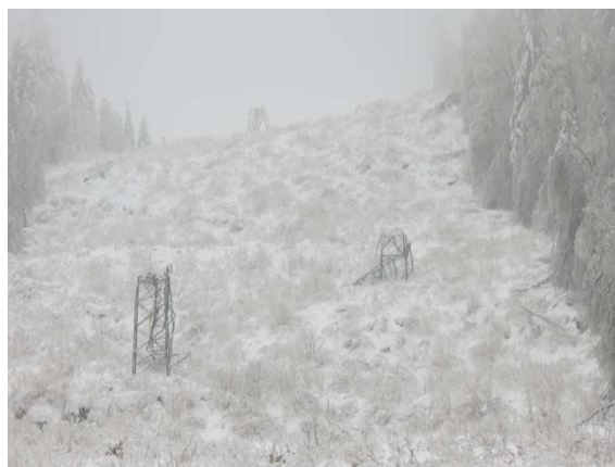
Slika 12. Pogled na katastrofalno stanje trase nakon ledene havarije [14-16]
