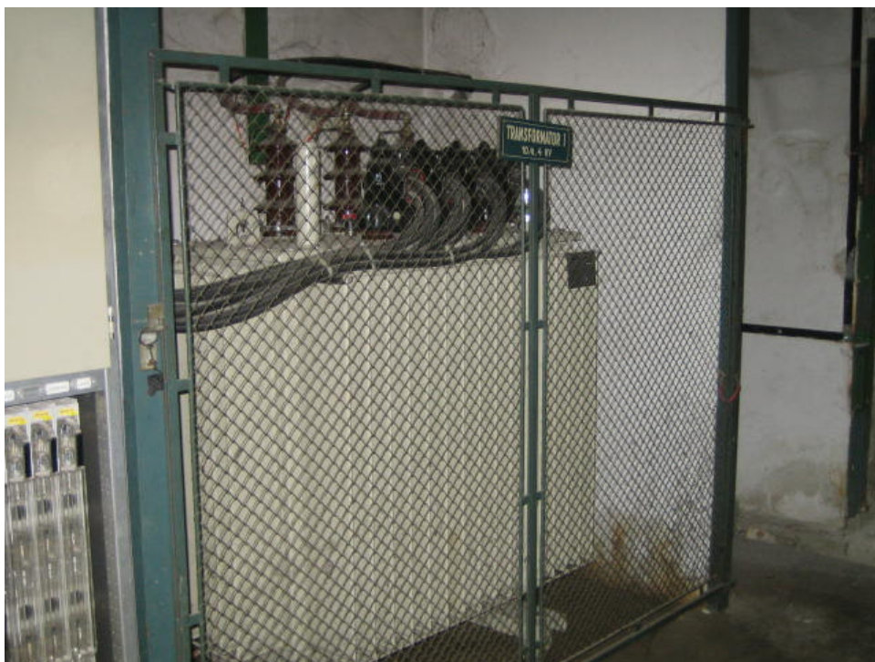
Slika 6. Transformator u rekonstruiranoj podrumskoj TS
