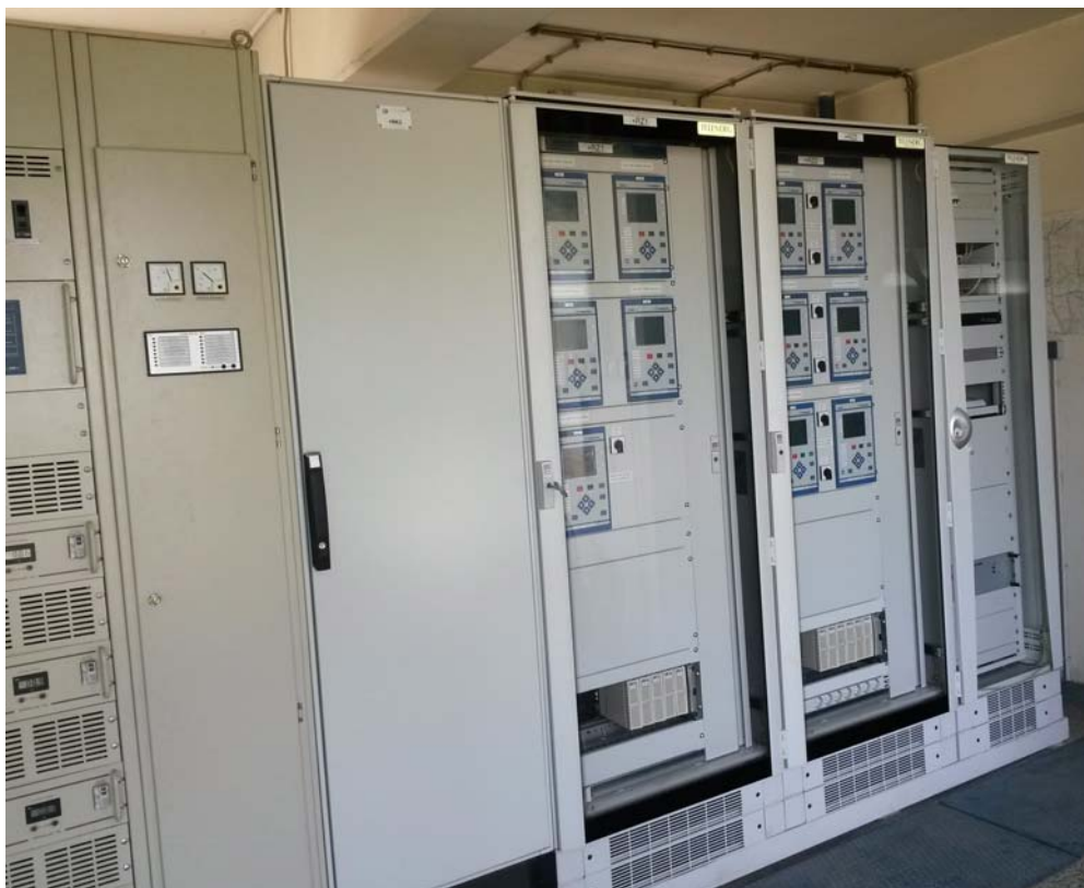
Slika 3. Sekundarni dio postrojenja nakon rekonstrukcije
