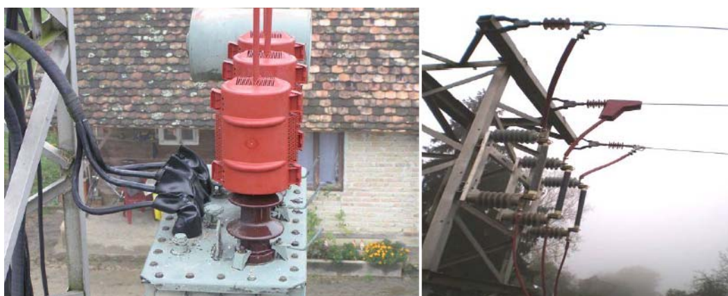
Slika 12. Prikaz izoliranja SN i NN priključaka na stupnoj trafostanici, te izoliranja strujnih mostova na stupnoj trafostanici
