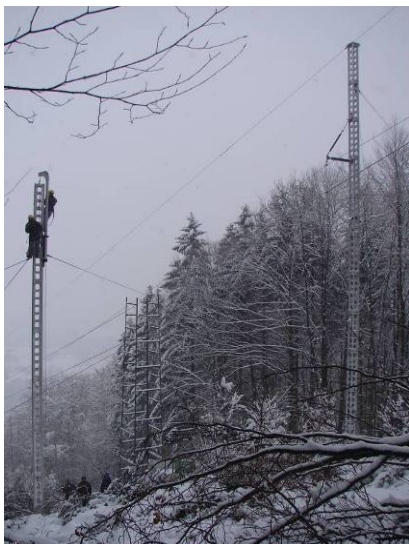
Slika 3. Montaža havarijskih stupova na DV 110 kV Hudo – Kočevje, EL [6,7]
