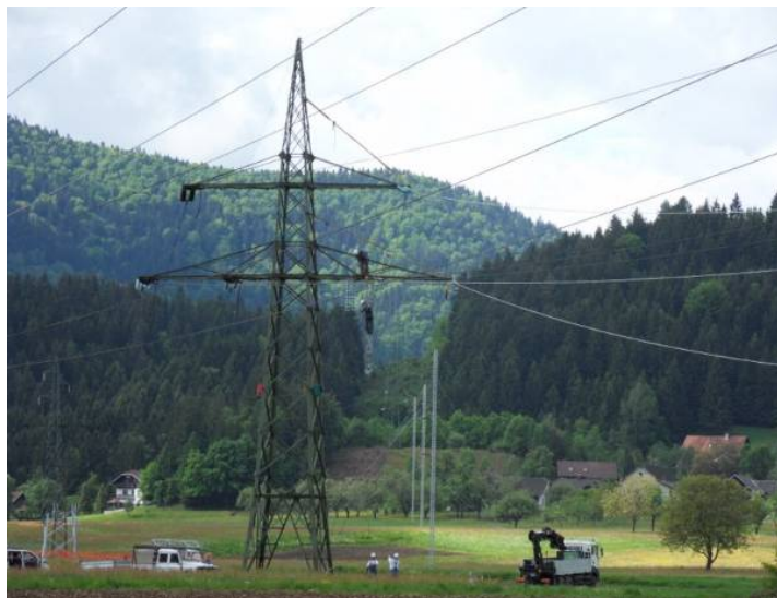
Slika 4. Montažni stupovi kod rekonstrukcije DV 110 kV Dravograd - Železarna Ravne, ELES [6,7]
